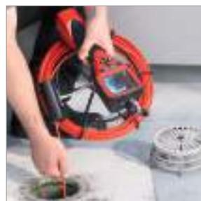
Телеинспекция ливневых труб
