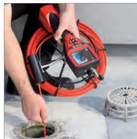
Телеинспекция ливневых труб
